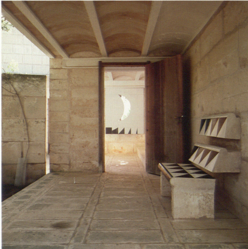
El marés, una piedra caliza de trabajo fácil, es el material base de una construcción donde el exterior se convierte en espacio de conexión entre todas las estancias. Mares, a limestone easy to work with, is the base material of a construction where the exterior space becomes the connexion between all the rooms.
