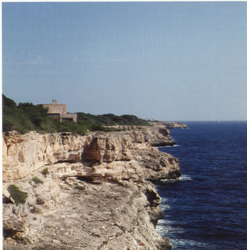
La vivienda está compuesta por un conjunto de pequeños edificios ortogonales orientados hacia el mar. The house is formed by a set of small orthogonal buildings facing the sea.
